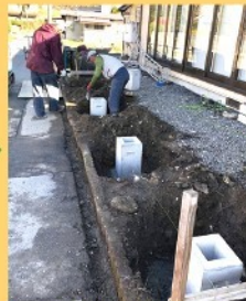
独立基礎 据付
