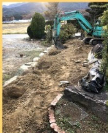
独立基礎 穴掘り
