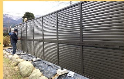
金具取付後 完成！
