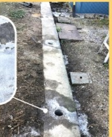
既存の敷地境界コンクリート土留め部分
