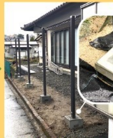
2段柱設置 独立基礎部分
