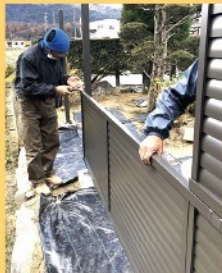
フェンス本体設置
