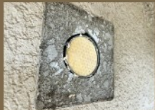
穴に断熱材を充填
