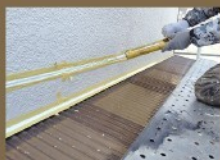
シーリング打ち
